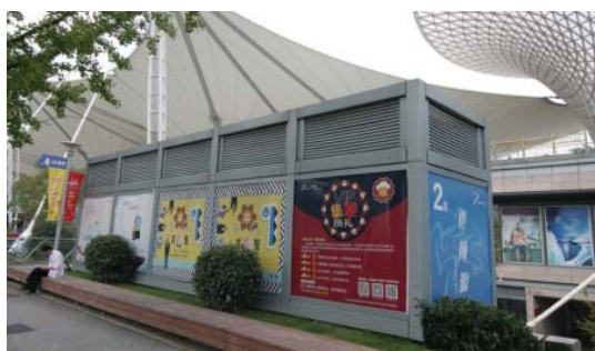
世博地区综合管廊建设
