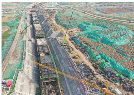
明挖现浇综合管廊施工
