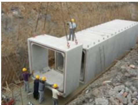
整节段预制拼装综合管廊
