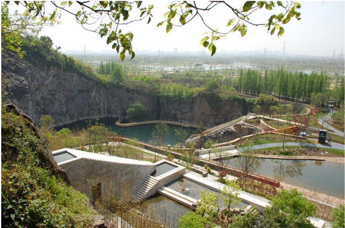
图 3-6 完成治理后的辰山采石坑
